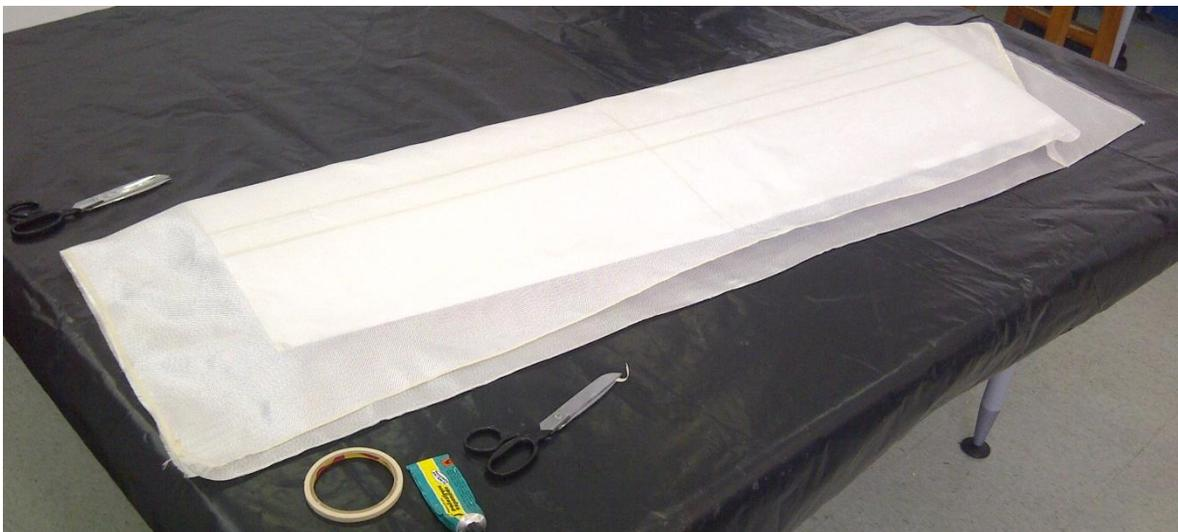
**Ilustración 158.- Corte y Adhesión de Fibra de vidrio sobre las alas; Proyecto Galapagos UAV**
