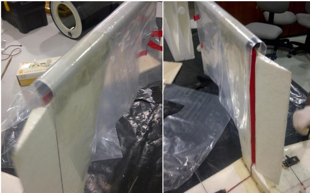
**Ilustración 211.- Resinado de Fibra de Vidrio para Junta de la Cola con Tubería; Proyecto Galapagos UAV**
