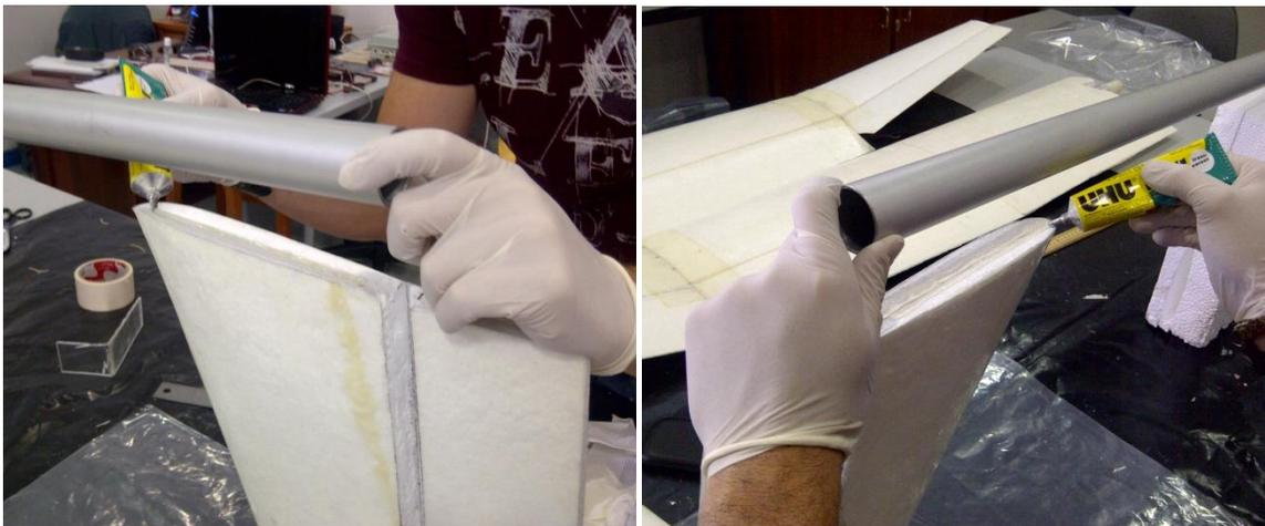
**Ilustración 207.- Resinado de Fibra de Vidrio para la Junta de la Cola; Proyecto Galapagos UAV**
