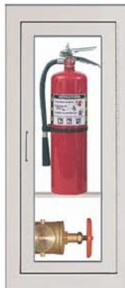
*Figura 2.43. Gabinete con Válvula Angular de 2-1/2 pulg y Extintor.*
