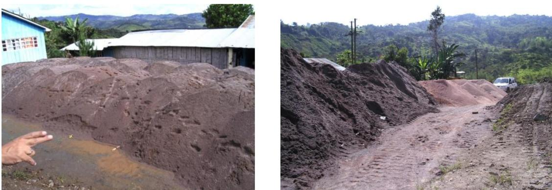
Figura 6.5 Colocación del material pétreo en el centro de gravedad del proyecto
