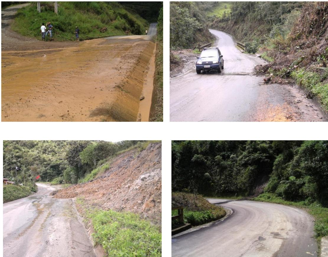
Figura 6.2 Presencia de daños sobre la vía (derrumbes, obstrucción del drenaje, basura, lodo etc.)
