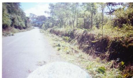
Figura 6.3 Trabajos sobre la vía (barrido de la vía y limpieza de cunetas)
