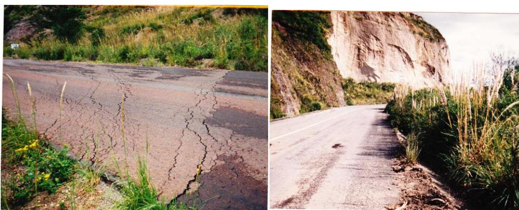
Figura 6.1 Patologías en la vía (piel de cocodrilo, fisuras transversales y longitudinales)
