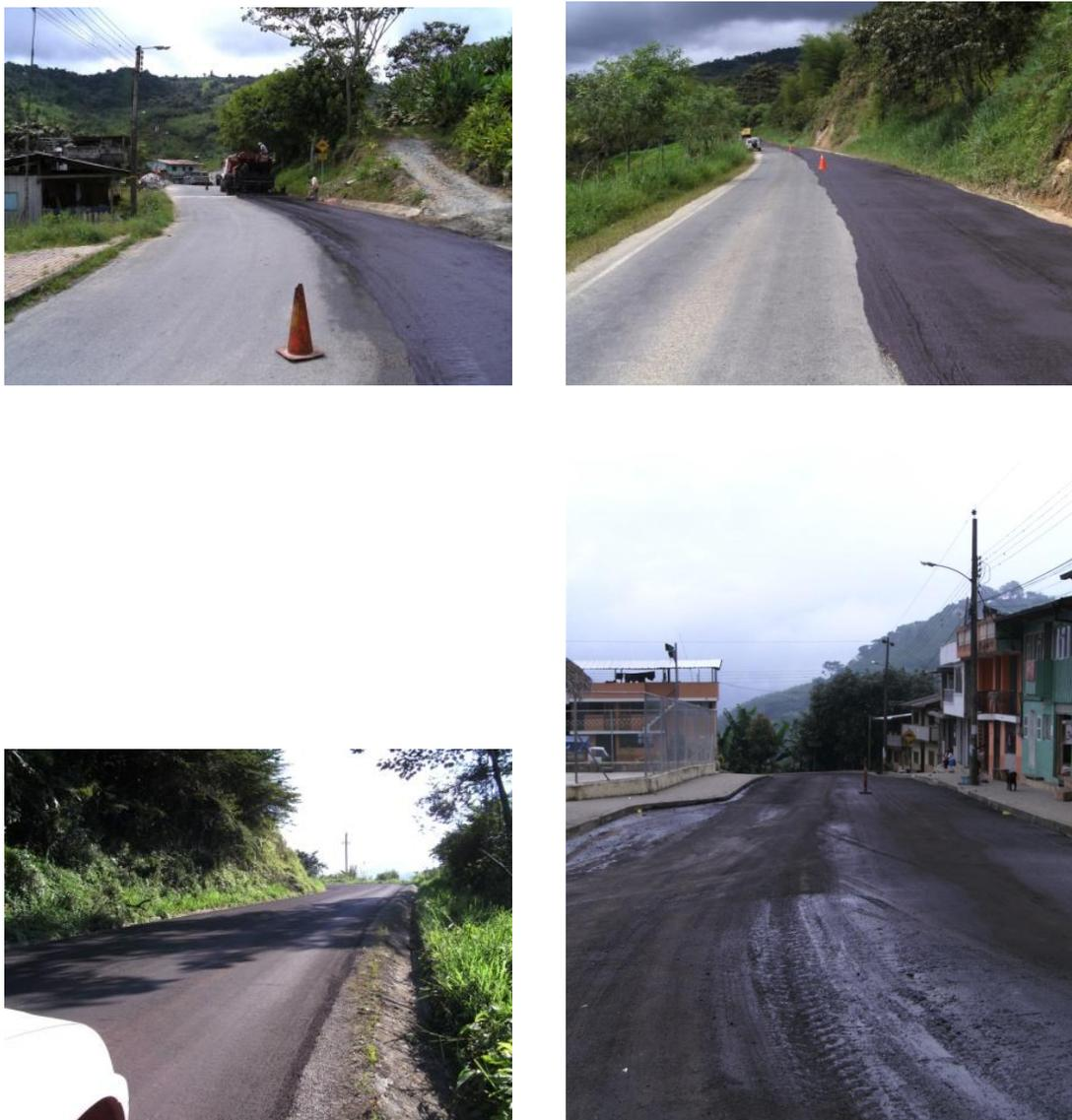
Figura 6.9 Colocación del mortero asfáltico Slurry Seal.
