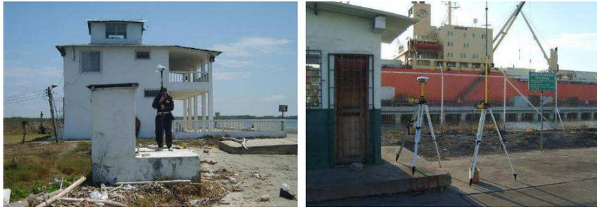
**FOTOS 3 Y 4.- Base DGPS y Rover.- Posicionamiento de un punto de apoyo a partir de la Red Oficial, para levantamiento del área de estudio.**
