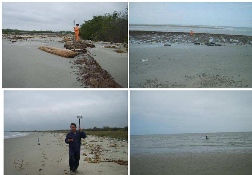
**FOTOS 5, 6, 7, 8.- Levantamiento de perfiles de playa en la zona Intermareal y detrás de la berma con la utilización del sistema DGPS en modo RTK.**
