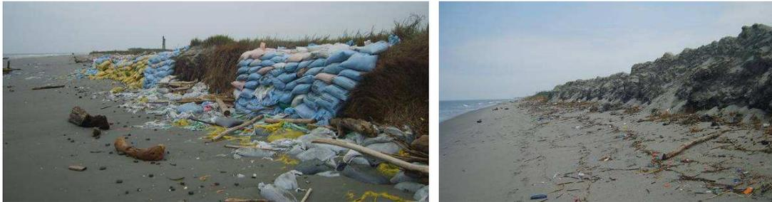
**FOTOS 44 Y 45.- Muros y obras de protección destruidos por el oleaje del mar, especialmente en las Sicigias y necesidad de protección temporal**
