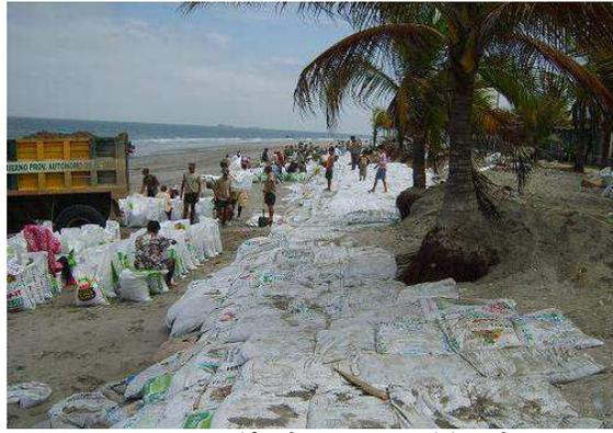
**FOTO 16.- Construcción de muro provisional con sacos de rellenos de arena recogida de la misma playa.**
