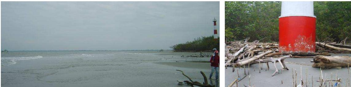
**FOTOS 41, 42 Y 43.- Actual Faro Jambelí inclinado y en peligro de colapsar por socavación de su base de sustentación.- Extremo norte de la Isla.**
