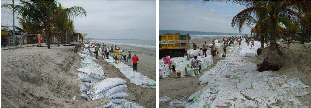
**FOTOS 1 Y 2.- Población de Jambelí efectuando minga para llenar sacos de arena que serán colocados como barrera provisional para la protección del malecón.**
