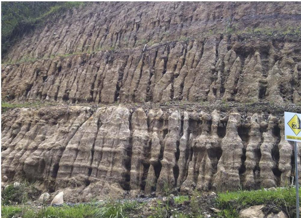
Ilustración 21, Erosión de talud en Barabón, Azuay
