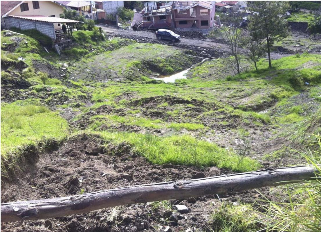
Ilustración 11, Deslizamiento por infiltración de agua
