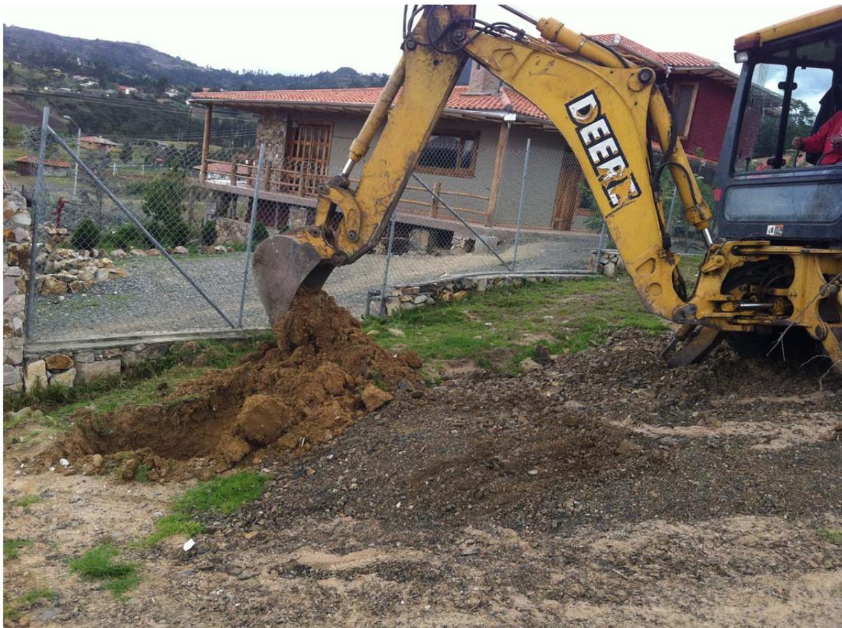
Ilustración 45, Calicata para obtención de muestra ensayo triaxia 1l
