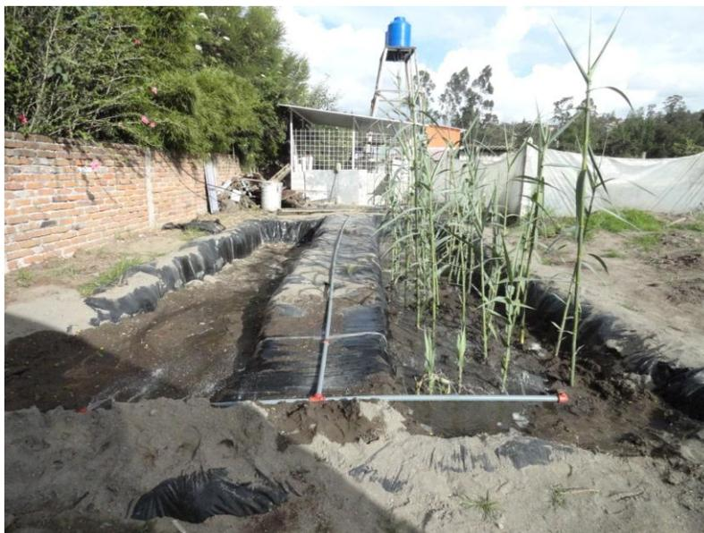
Figura 3.4.2: Humedales artificiales de la granja, en la izquierda se encuentra el humedal de control y a la derecha el humedal con las macrófitas. Se muestra que el sistema de alimentación es por medio de tuberías perforadas, cada humedal recibe un caudal promedio de  $1,2 \text{ m}^3/\text{hora}$ , y un total de  $2,4 \text{ m}^3/\text{hora}$ . (Fotografía por Luis Esteban Guerra)
