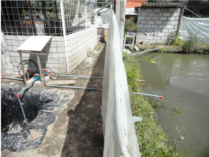
Figura 3.4.1: Sistema de bombeo de recirculación, se succiona agua desde el fondo del reservorio, y el efluente se lo descarga en la superficie del reservorio. (Fotografía por Luis Esteban Guerra)
