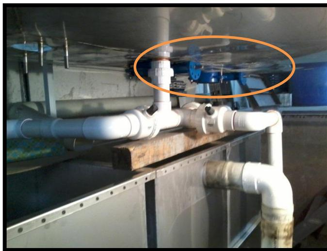
Figura 4.19: Válvula de mariposa de desagüe del sumidero antes de reforzar su sujeción.
