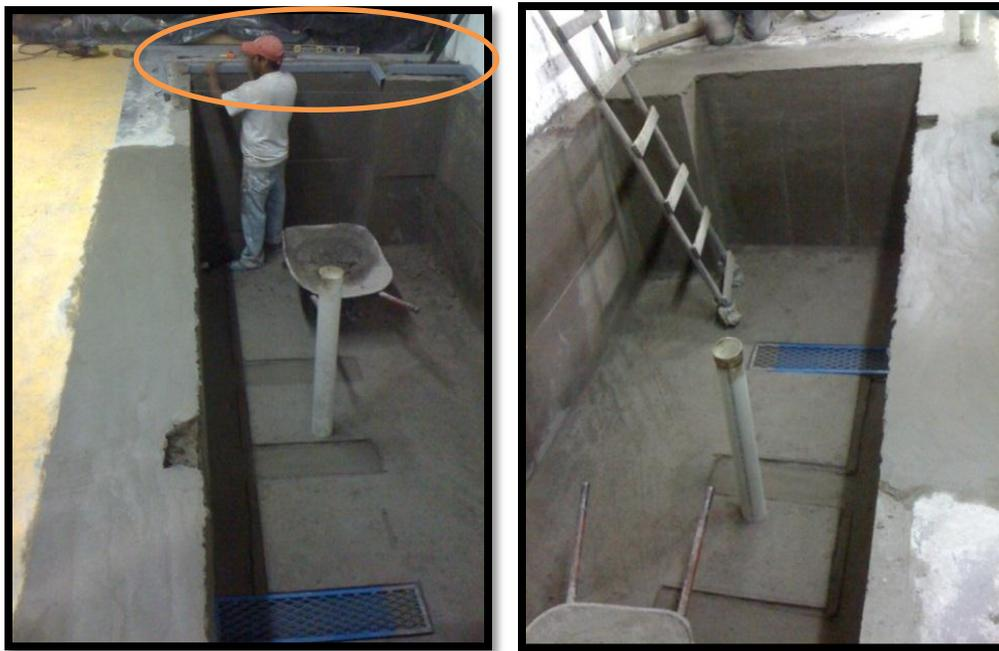
Figura 4.3: Cimentación y caja de concreto casi finalizada.
