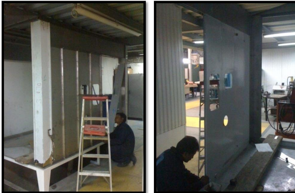
Figura 4.11: Montaje de las paredes internas a la estructura principal.
