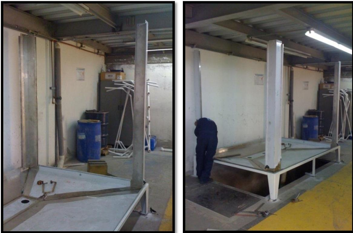
Figura 4.7: Montaje de las columnas principales en el conjunto base sumidero.
