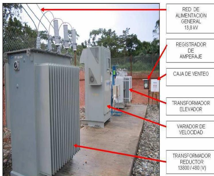
Figura 2.6 Equipo de superficie Bomba Electrosumergible Campo Libertador
