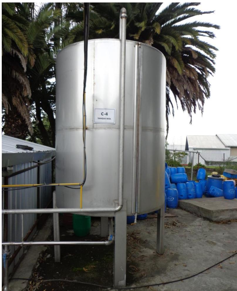
**Figura 4.10: Tanque almacenamiento de biol**
