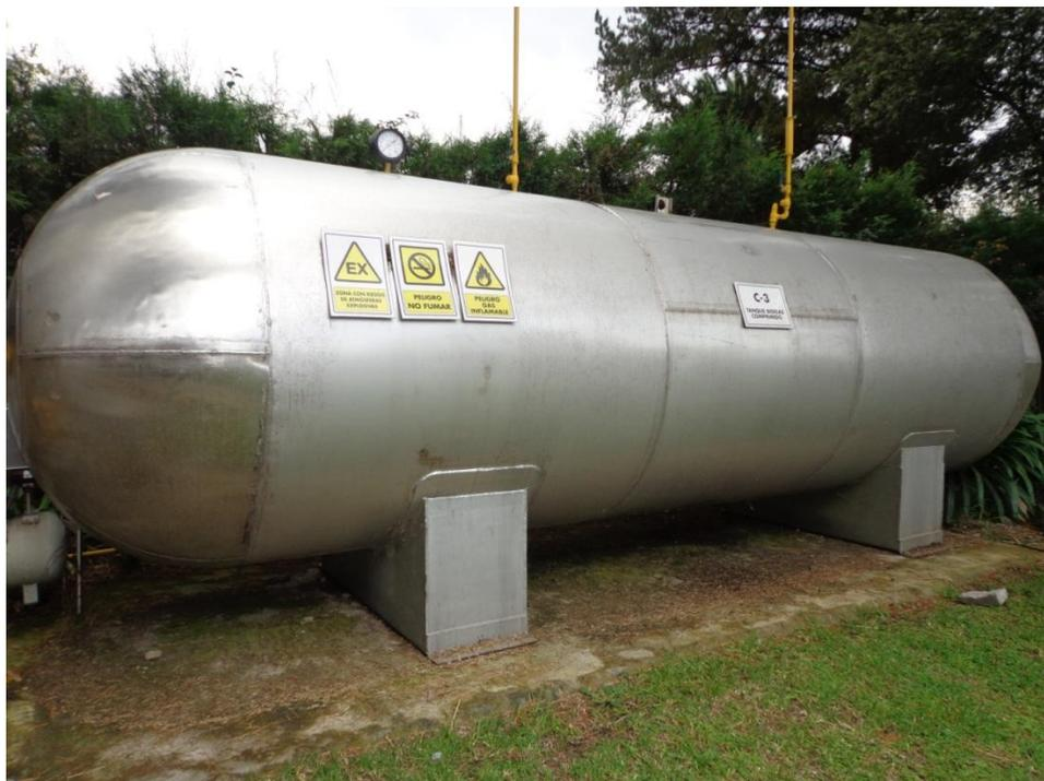
**Figura 4.18: Bala de almacenamiento de biogás a presión**
