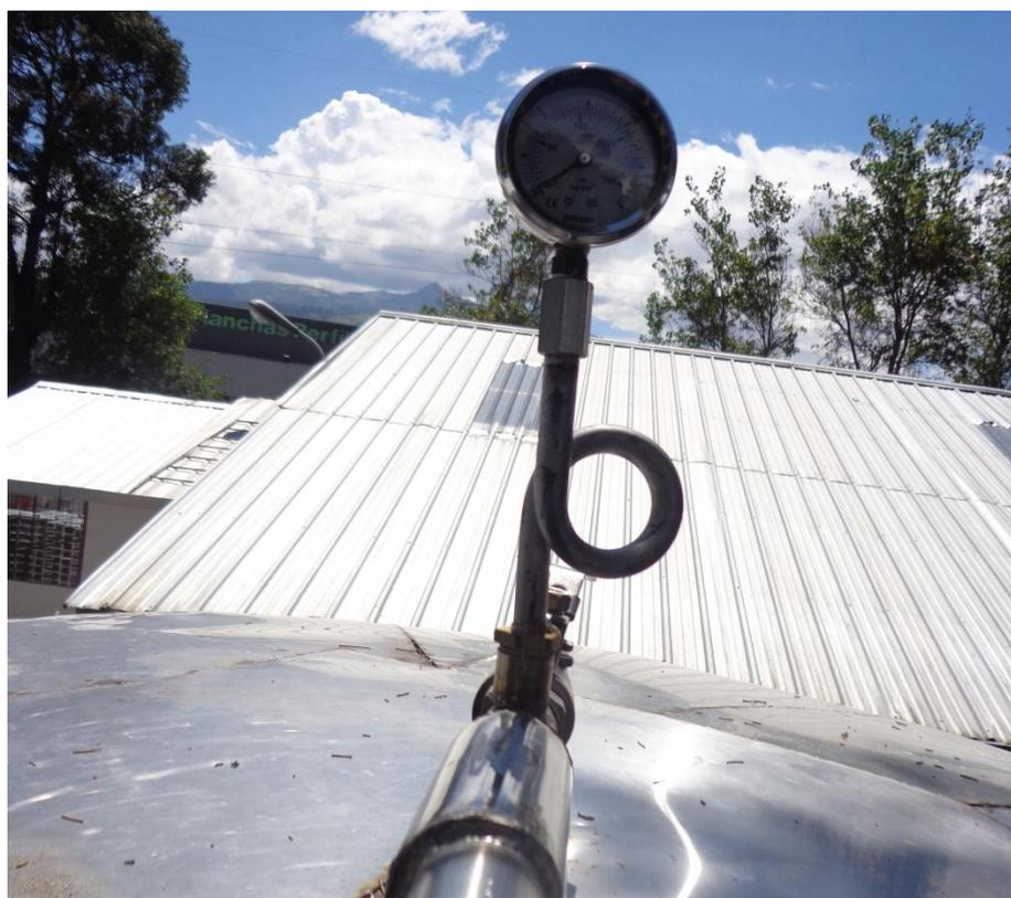
**Figura 4.13: Salida de biogás.**
