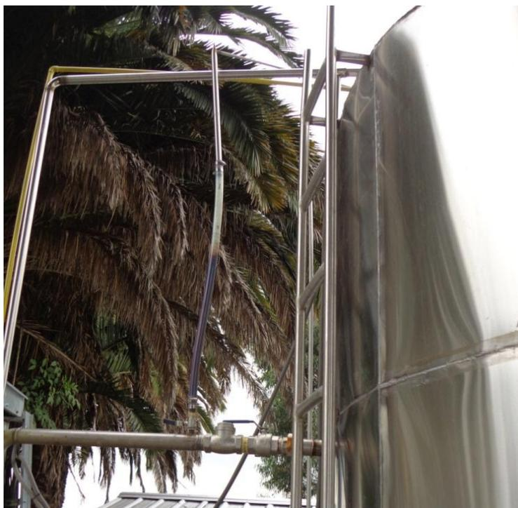
**Figura 4.25: Medidor de nivel visual**
