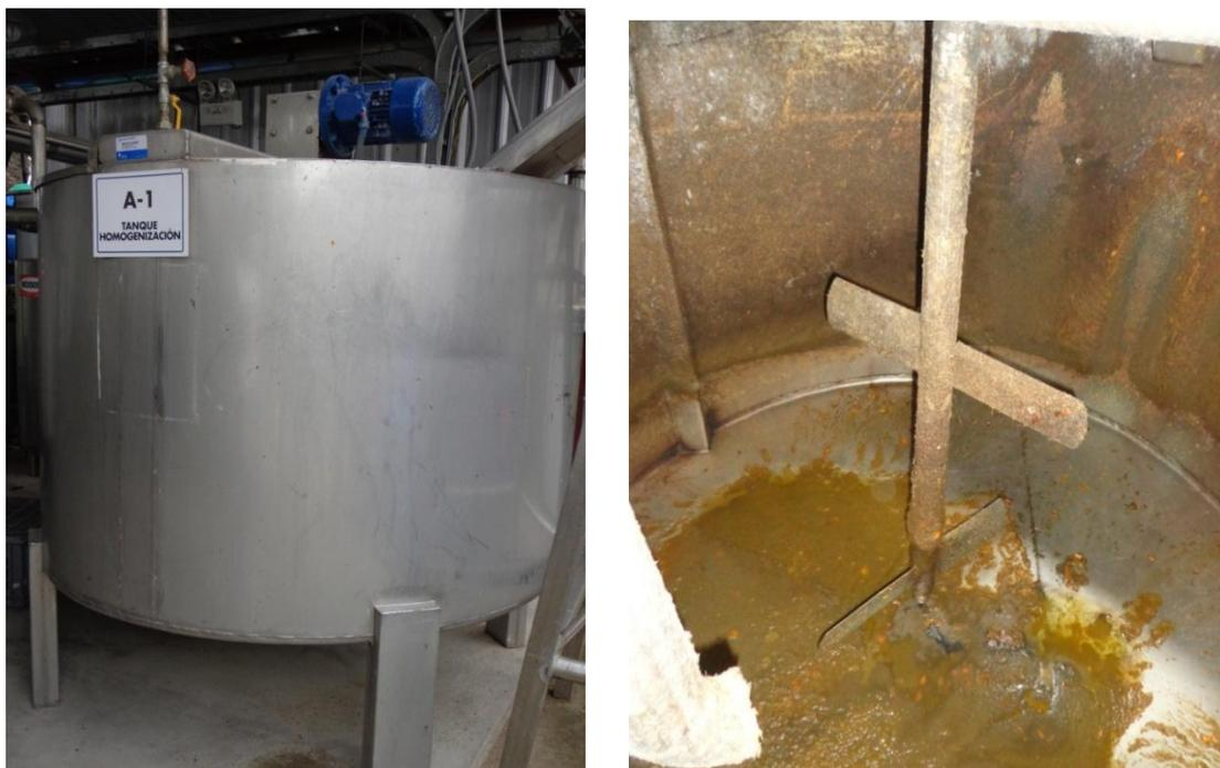
**Figura 4.6: (a) Tanque de homogeneización (b) Agitador**
