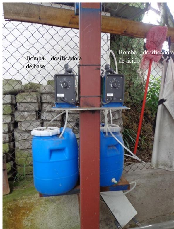
**Figura 4.27: Sistema de control automático de pH**
