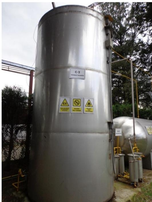
**Figura 4.16:** Tanque pulmón de almacenamiento de biogás
