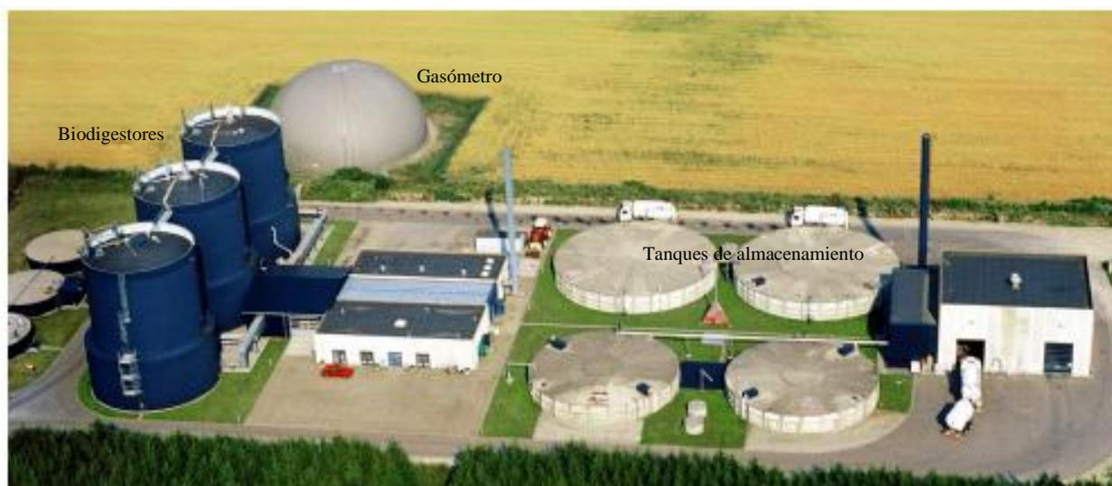
**Figura 2.6: Planta de co-generación en Dinamarca. Lemvig Biogás. (14)**
