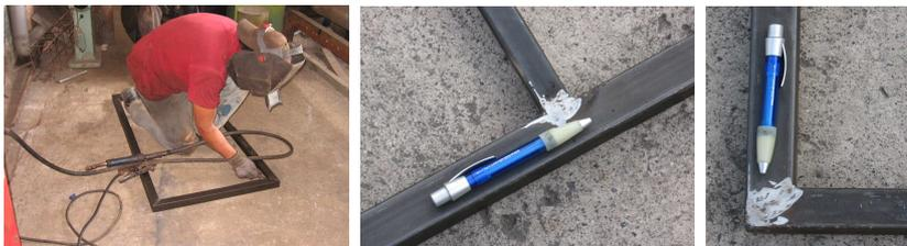
Foto 4.3.- Suelda de los perfiles.
