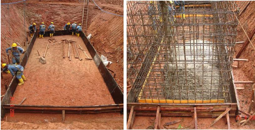
*Foto 1.11.- Encofrado de losa de API*
