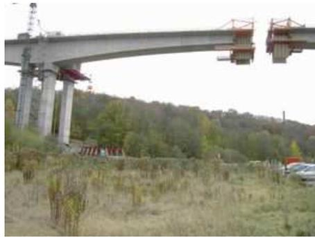
*Foto 1.8.- Encofrado deslizante*
