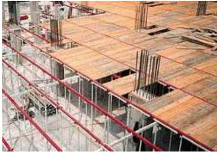
*Foto 1.3a.- Encofrado de losa*
