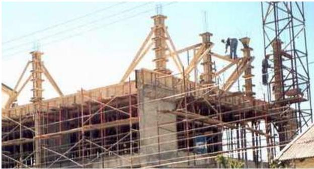
*Foto 1.1a.- Encofrado de columnas rectangulares*
