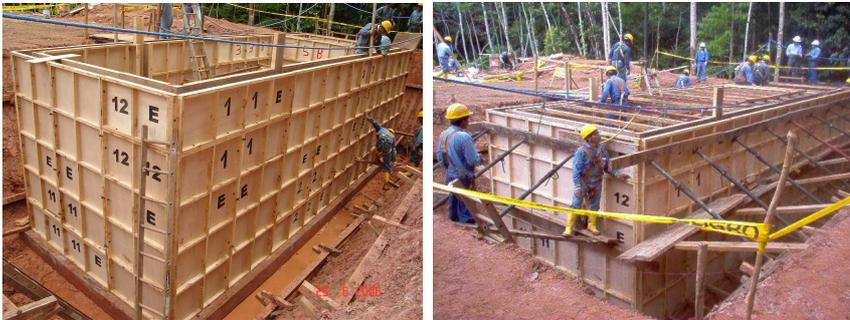
*Foto 1.12.- Encofrado de paredes de API*
