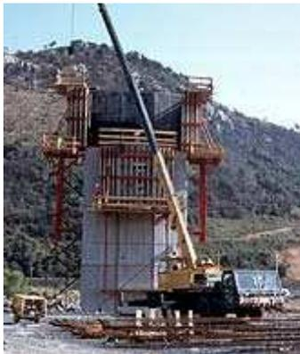
*Foto 1.6.- Encofrado trepador para pilas y torres*
