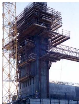
*Foto 1.7.- Encofrado deslizante para pilas y torres*
