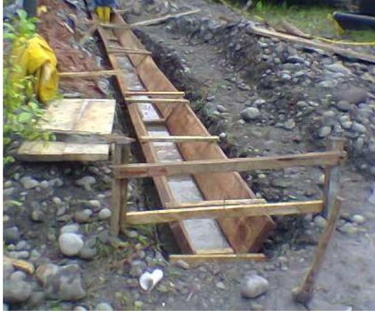
Foto 1.5.- Encofrado de cunetas
