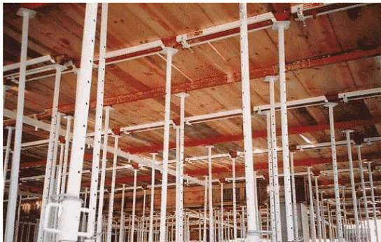
*Foto 1.3b.- Encofrado de losa*
