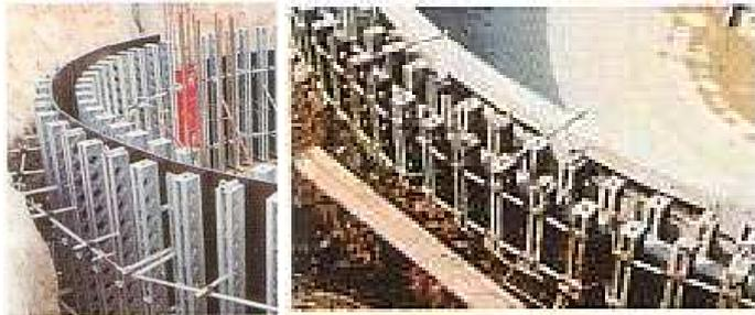
Foto 1.4.- Encofrado de un muro curvo
