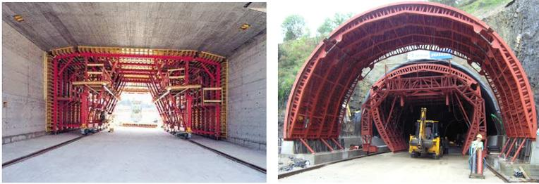
*Foto 1.9.- Encofrado telescópico autoportante para túnel*
