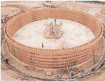
*Foto 1.13.- Encofrado de tanques*
