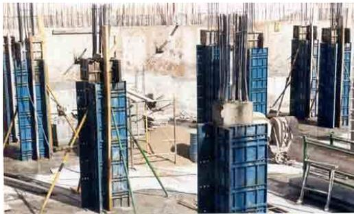
*Foto 1.1b.- Encofrado de columnas rectangulares*
