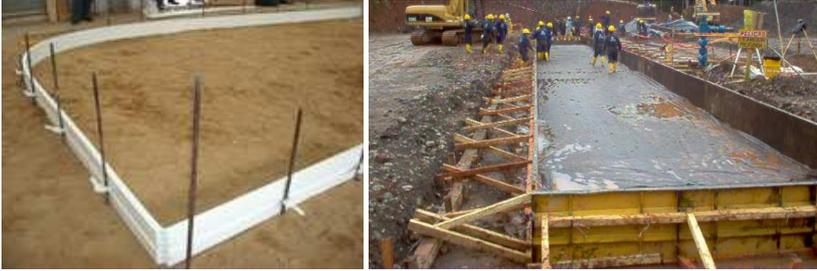
*Foto 1.2.- Encofrado de losas de cimentación*
