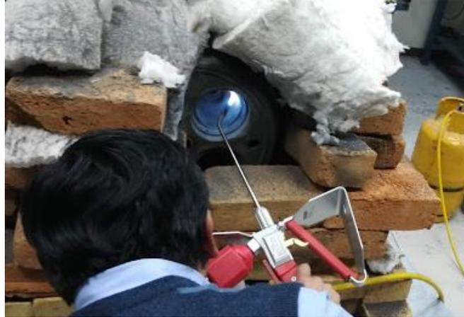
**Figura 22.** Capa inicial de NiCrBSiFe para evitar oxidación en el área de trabajo.
