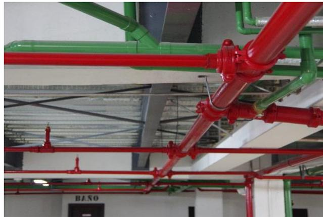
Figura #17. Ejemplo de tuberías contra incendio (Rueda Duarte, 2018).
