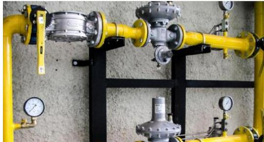
Figura #16. Ejemplo de sistema de tuberías de gas o combustible (Rueda Duarte, 2018).
