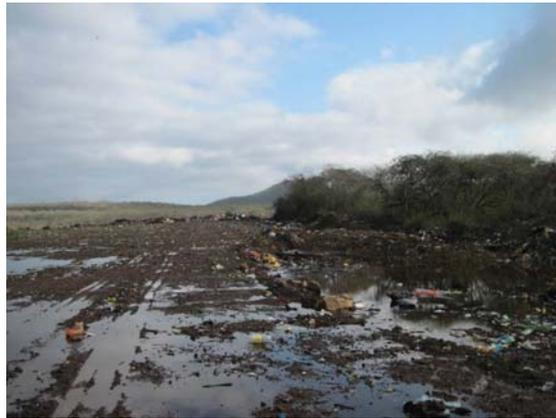
Foto 13: Lluvias acumulan agua por falta de cunetas y drenaje, la falta de cobertura ocasiona mayor generación de lixiviados.
