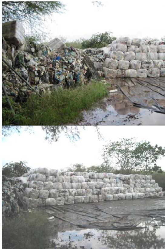
Foto 17: Sitio de disposición de material de rechazo sobre una geomembrana dispuesta en el suelo
