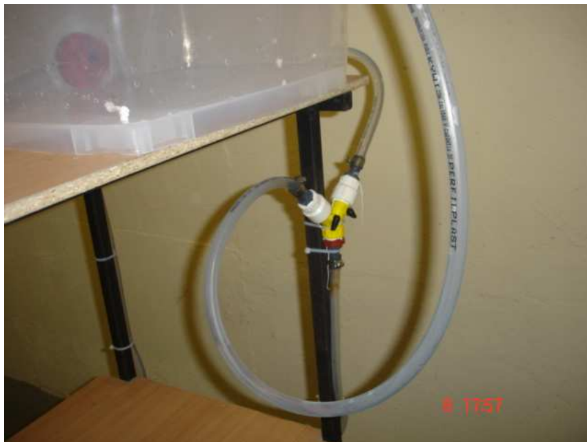
Figura 6: Regulador de nivel para el tanque de carga
