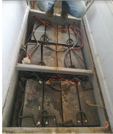
Figura 1. Baterías del bote Tapiatpia. (Kara Solar, 2019).
