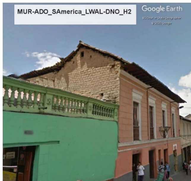
Figura 26. Vivienda de tipología 11
