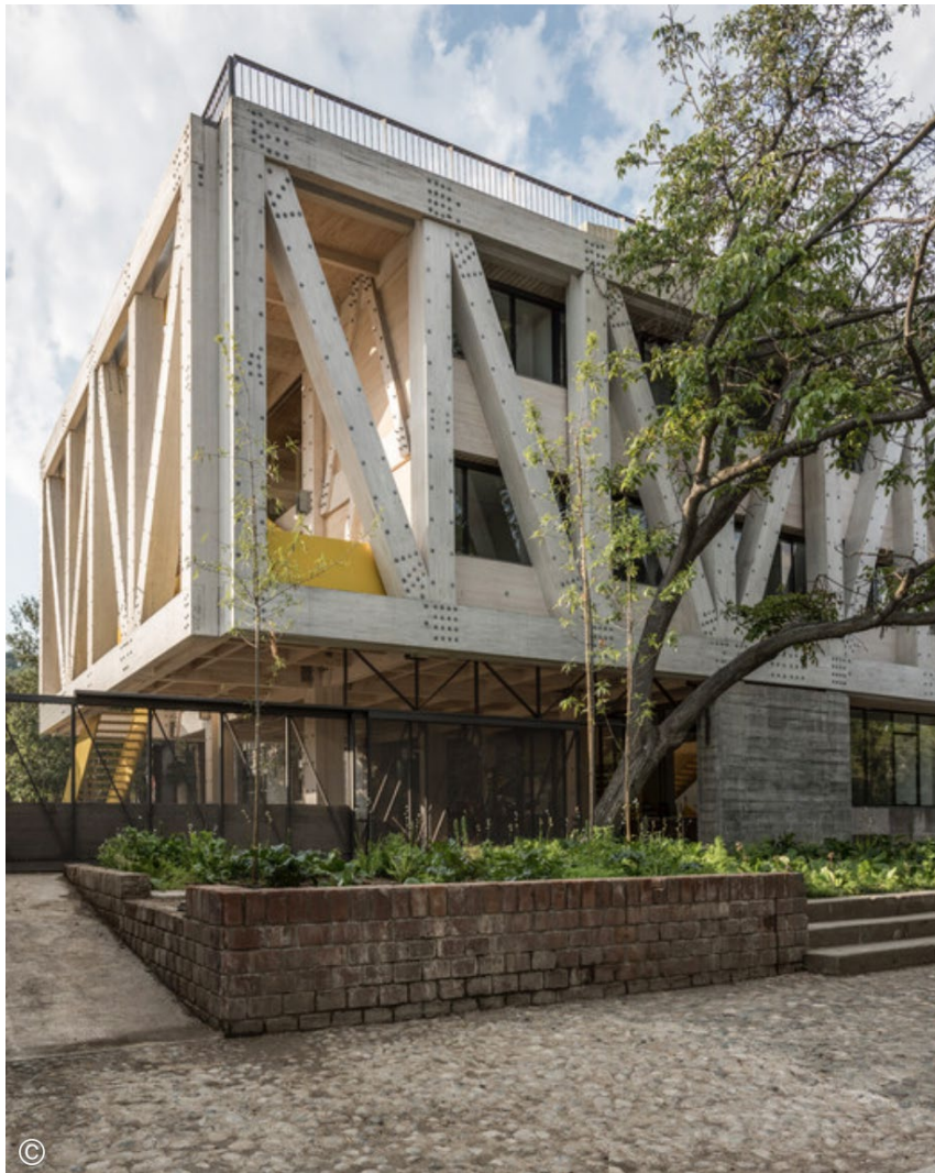
Figura 5. Edificio Escuela de Arquitectura UC.
