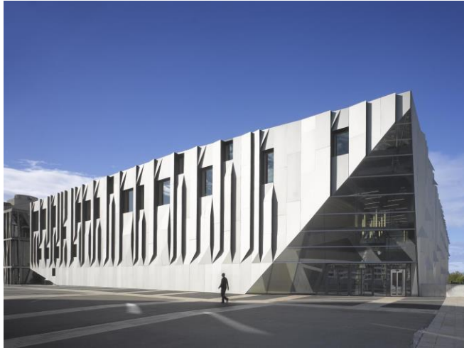
Figura 14. Conservatorio de música Aix. Recuperado desde https://www.plataformaarquitectura.cl/cl/623388/conservatorio-de-musica-de-aix-en-provence-kengo-kuma-and-asociados/53b4f374c07a8005ce0000a1-aix-en-provence-conservatory-of-music-kengo-kuma-and-associates-photo
