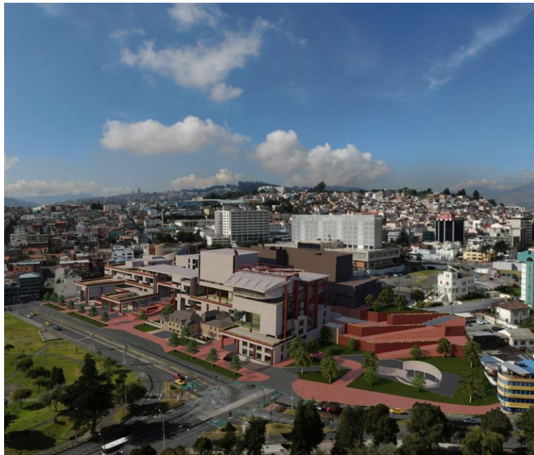
Figura 19. Axonometría. Elaboración por Daniel Merchan, Daniel Chiriboga, Adrian Silva y Antonella Jaramillo.
