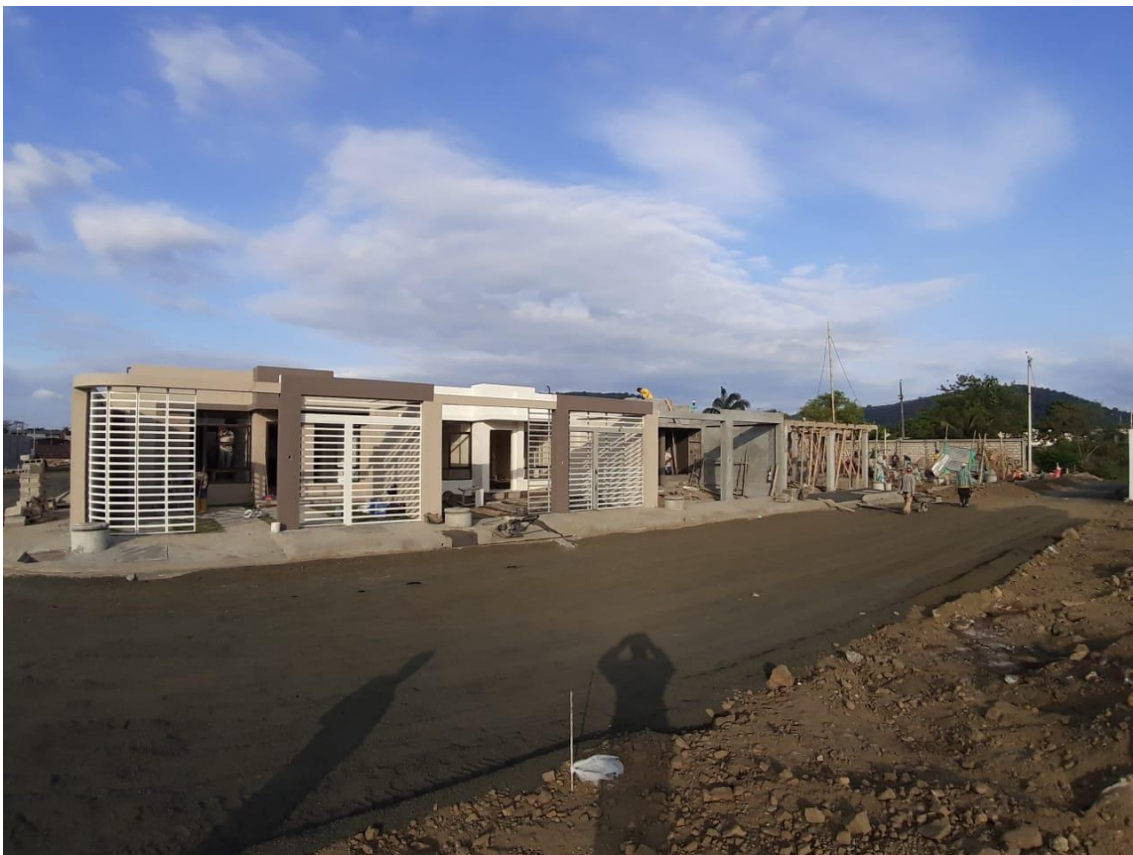
Anexos 14: Construcción de infraestructura en Ciudadela Alania Norte Capturada: Daniel Párraga.
