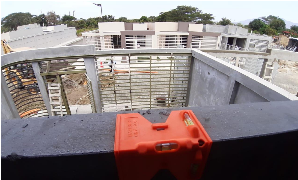
Ilustración 79: Control de calidad / Pruebas de nivel Elaborado por: Daniel Párraga.
