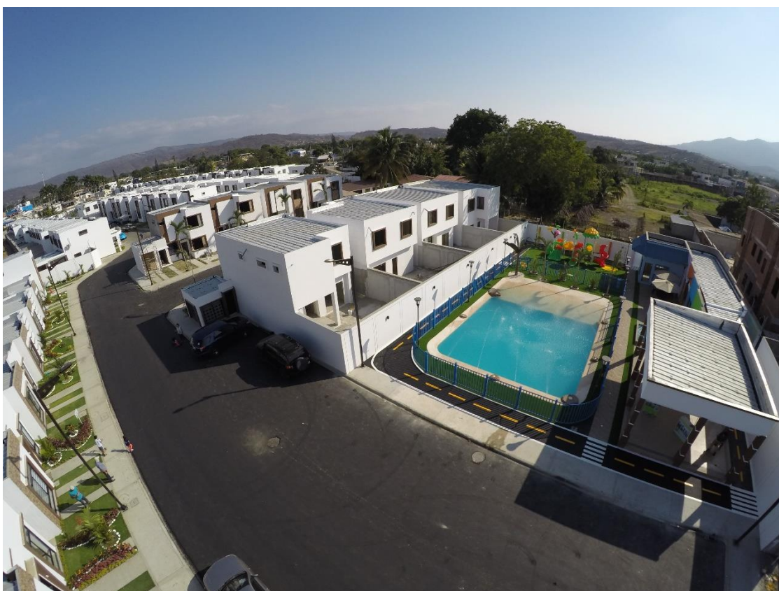
Ilustración 45: Área social en Urbanización Portoviejo Real 2 Fuente: Indeco S.A
