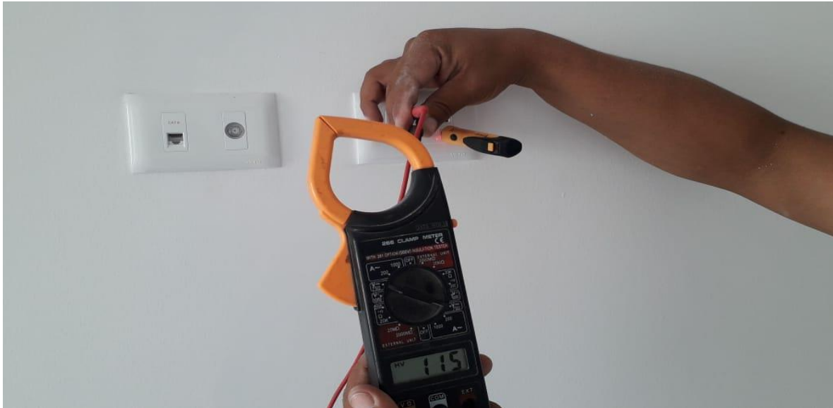
Ilustración 78: Control de calidad / Pruebas técnicas eléctricas Elaborado por: Daniel Párraga.
