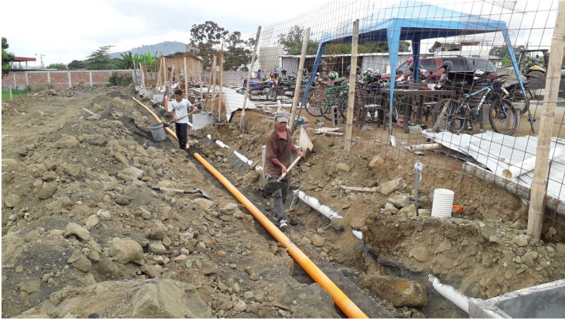
Anexos 13: Construcción de infraestructura en Ciudadela Alania Norte Capturada: Daniel Párraga.
