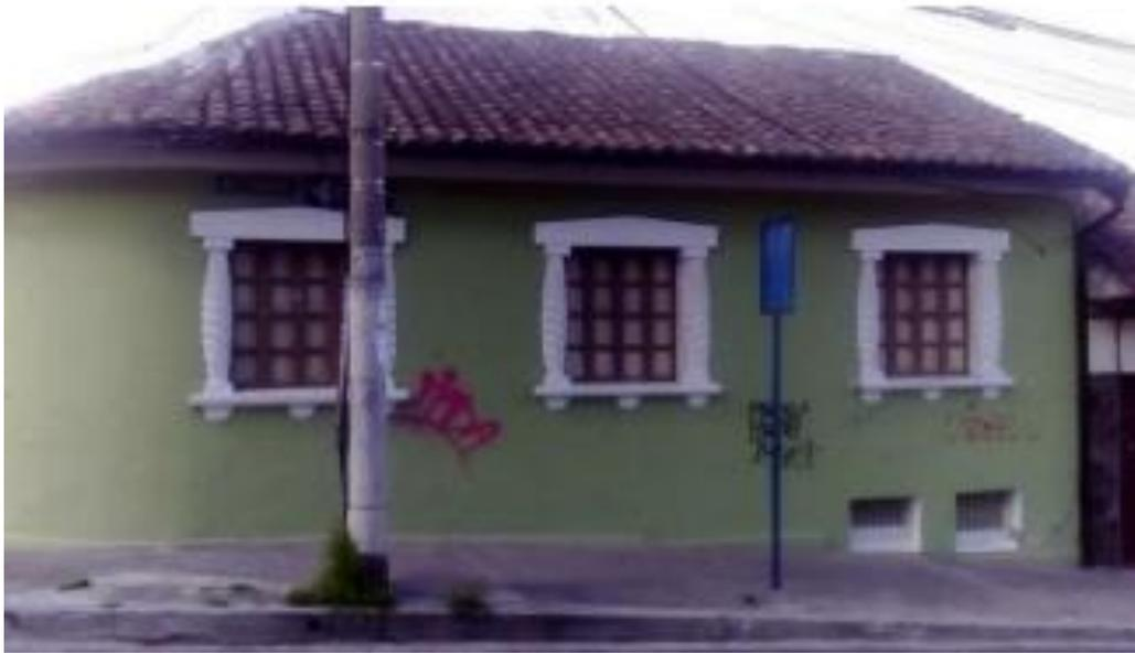
Figura 3: Fotografía de una vivienda residencial con una tipología estructural de mampostería sin reforzar con paredes de adobe no dúctil (Ayala et al, 2017).
