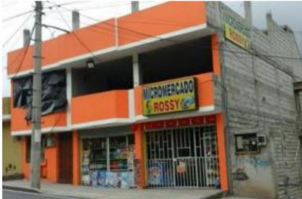
Figura 2: Fotografía de una vivienda residencial con una tipología estructural de hormigón armado, losas planas y pórticos rellenos no dúctil (Ayala et al, 2017).
