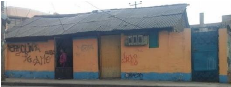
Figura 14: Fotografía de una vivienda residencial con tipología estructural de tierra
