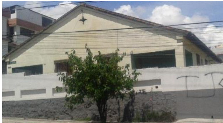
Figura 8: Fotografía de una vivienda residencial con tipología estructural de pórticos rellenos de hormigón armado hecho en sitio, no dúctil (Ayala, Sosa, & Chicaiza, 2017)
