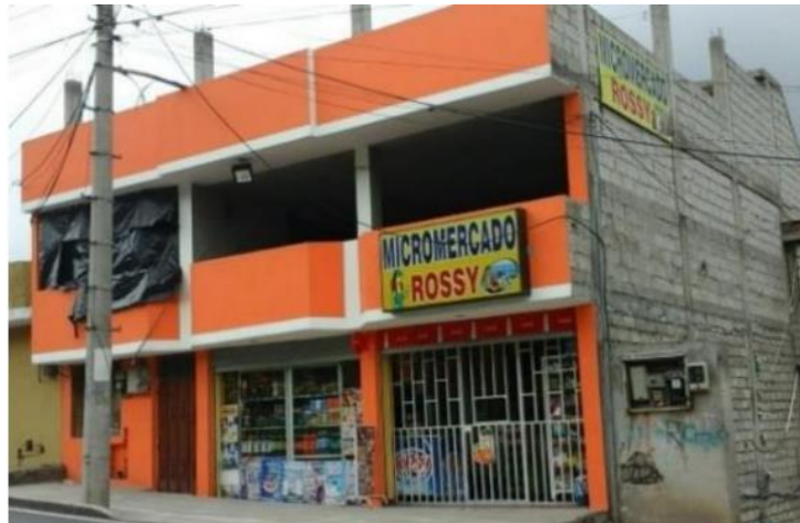
Figura 2: Fotografía de una vivienda residencial con tipología estructural de hormigón armado hecho en sitio con losa plana y pórtico relleno, no dúctil (Ayala, Sosa, & Chicaiza, 2017).
