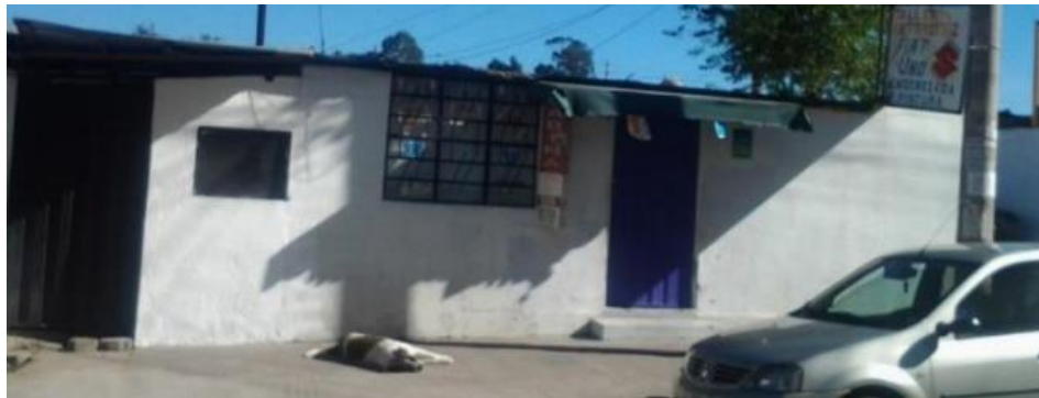
Figura 10: Fotografía de una vivienda residencial con tipología estructural de mampostería sin reforzar con bloques de hormigón muros con aberturas, no dúctil
