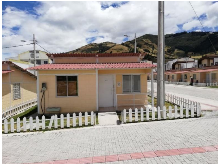
Figura 15: Fotografía de la vivienda residencial unifamiliar de un piso (Angulo, 2020).
