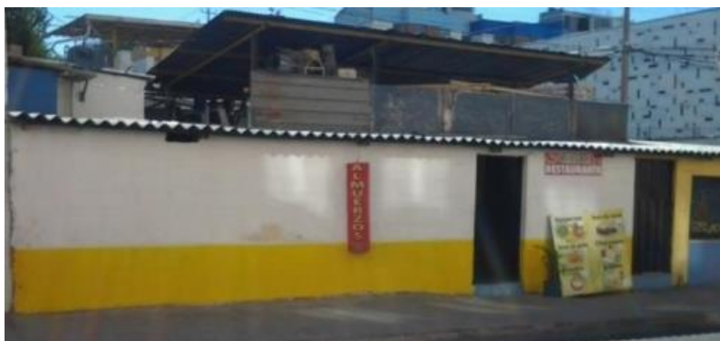
Figura 12: Fotografía de una vivienda residencial con tipología estructural de madera (Ayala, Sosa, & Chicaiza, 2017)
