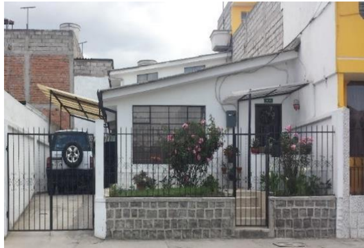
Figura 3: Fotografía de una vivienda residencial con tipología estructural de hormigón armado hecho en sitio con postes y vigas, no dúctil (Ayala, Sosa, & Chicaiza, 2017)
