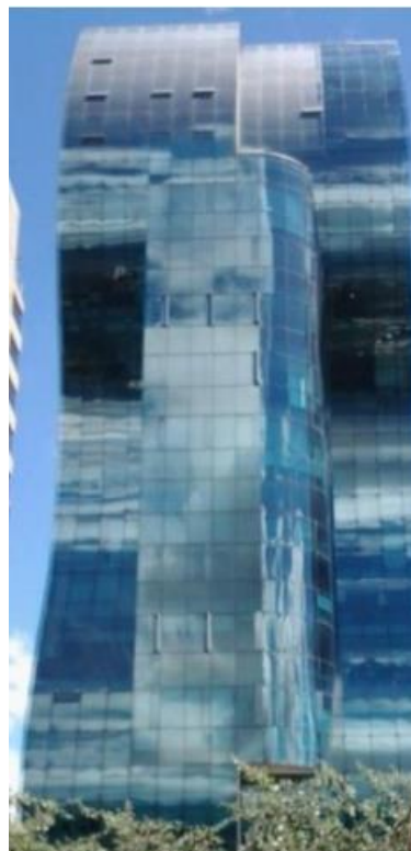
Figura 13: Fotografía de una vivienda residencial con tipología estructural de acero
