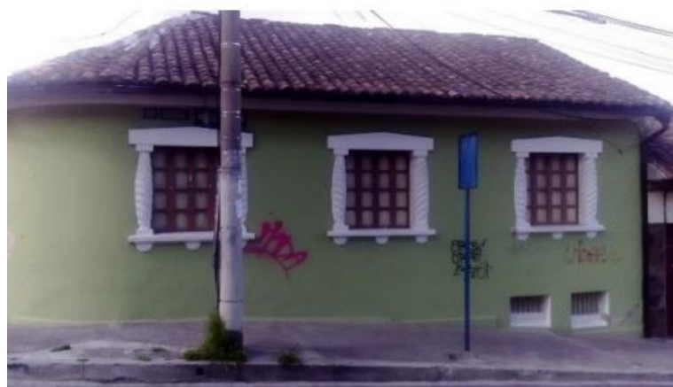
Figura 9: Fotografía de una vivienda residencial con tipología estructural de mampostería sin reforzar con paredes de adobe, no dúctil (Ayala, Sosa, & Chicaiza,
