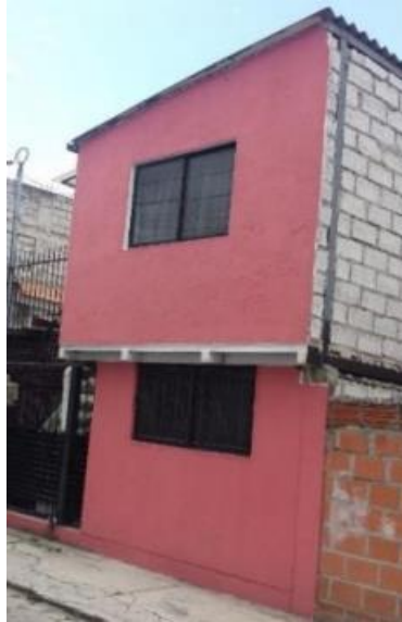
Figura 5: Fotografía de una vivienda residencial con tipología estructural de hormigón armado en sitio híbrido, no dúctil (Ayala, Sosa, & Chicaiza, 2017)
