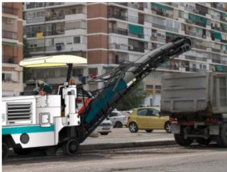
Figura 4: fresado de vía. (Pavimentos, sf)
