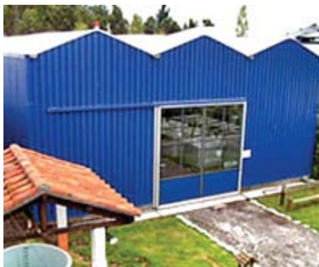
Foto 7: Caseta de Riego y Bombas
