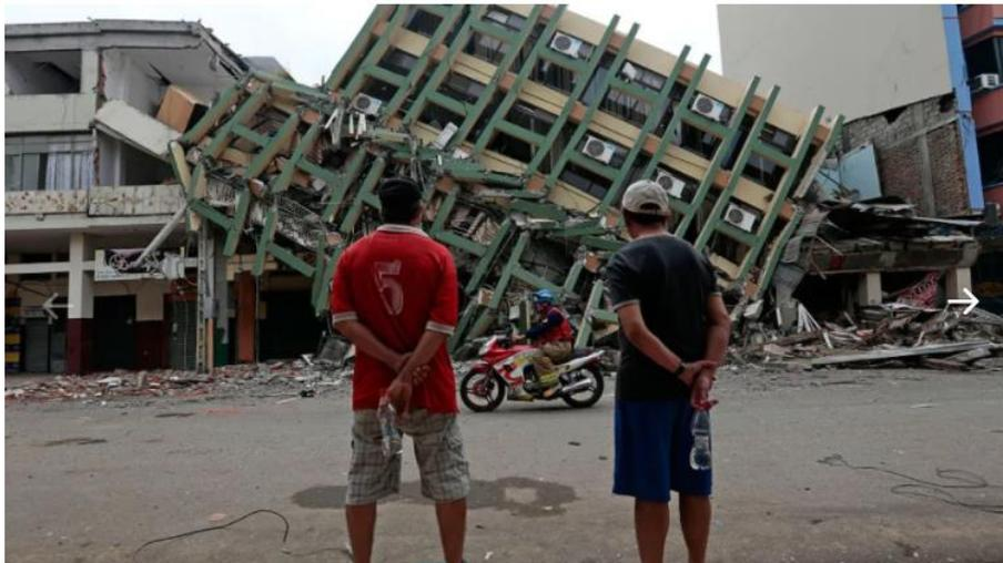
*Figura 3. Edificación colapsada en Pedernales.*
