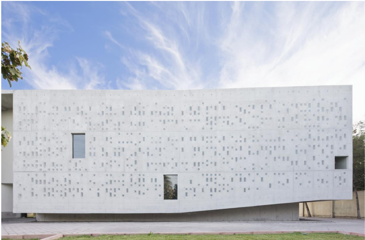
Figura 7. Materialidad Fachada Memorial de la Solidaridad. Plataforma Arquitectura
