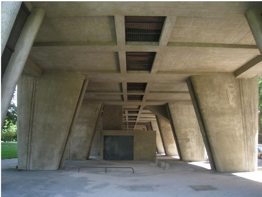
Figura 6. Pilotes, Unité d'Habitation. Plataforma Arquitectura
