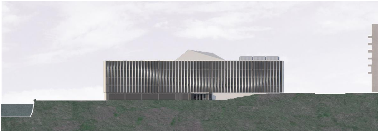
Figura 24, Fachada sur. Carrión, B.
