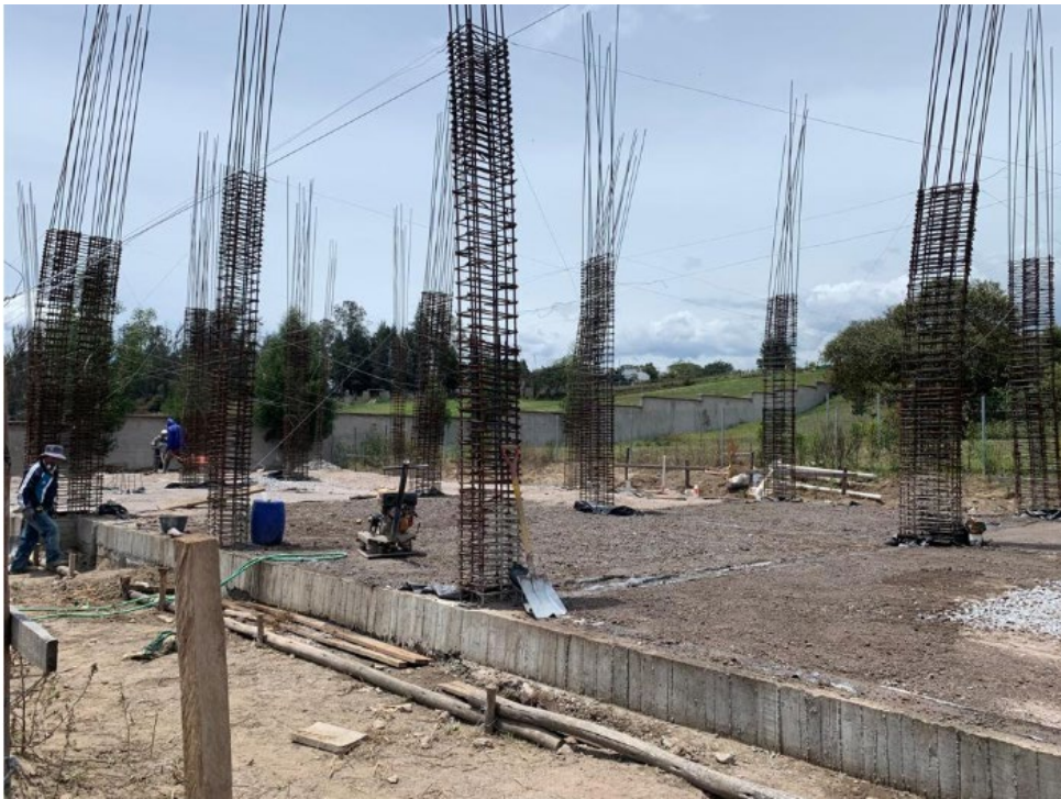
Figura 18. Elevación de contrapiso
