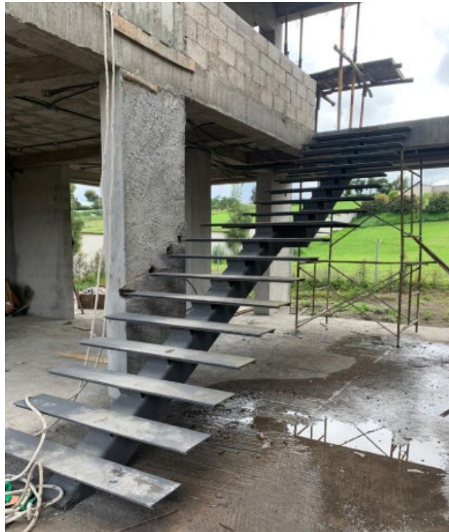
Figura 17. Estructura metálica de grada
