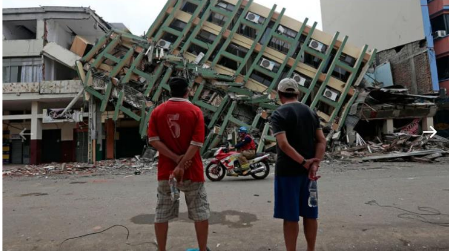
Figura 3. Edificación colapsada en Pedernales. Fuente. CNN Español, La huella del terremoto en Pedernales. 2016. Vía web.
