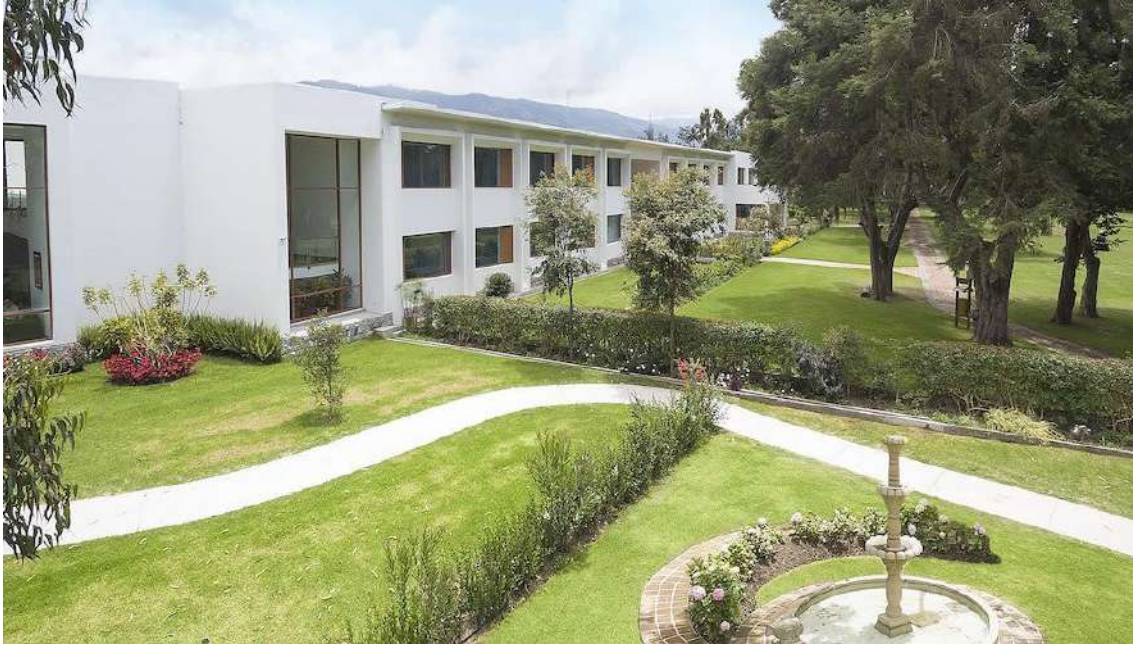
Ilustración 4. Edificio Bamboo San José de Puenbo Vista Lateral
