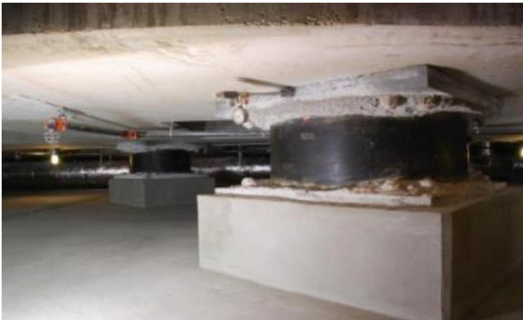
*Ilustración 2: Apoyo elástometrico.*
