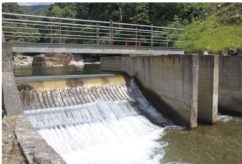
Ilustración 18 - Fotografía de malla coanda en El Laurel
