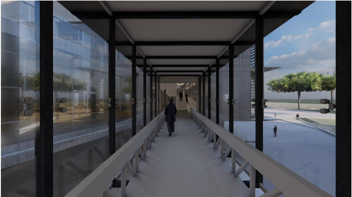
Figura 40. Vista Interior Puente. Elaboración propia.
