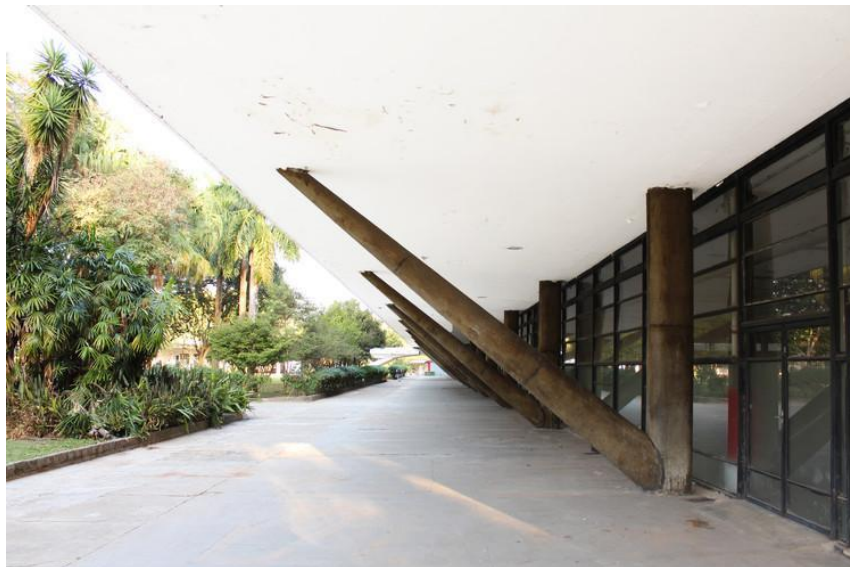
Figura 19. Columnas angulares, Palácio dos Estados. Matheus Pereira, 2018.
