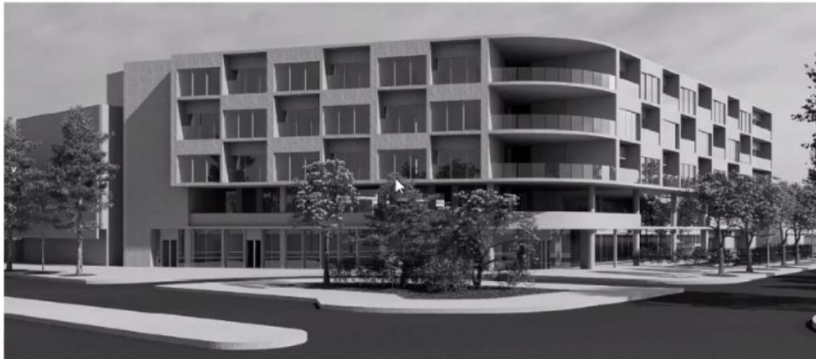
Gráfico # 25. Fachada exterior, Novotel
