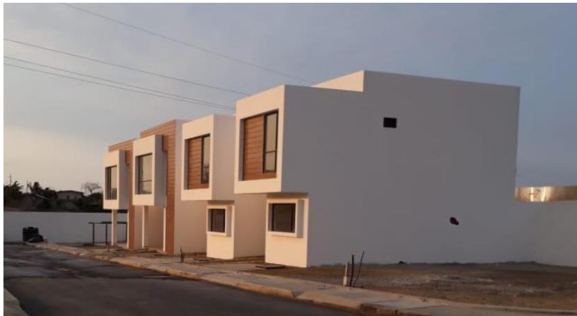
Figura 155 Fotos de la vivienda modelo finalizada su construcción.
