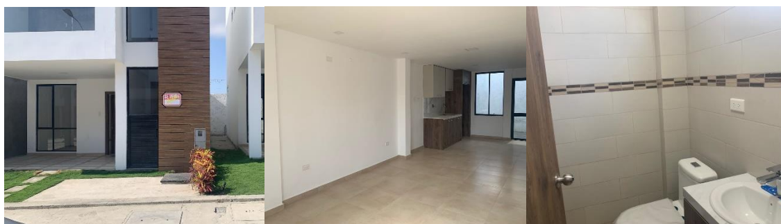
Figura 114 Acabados paredes viviendas construidas
