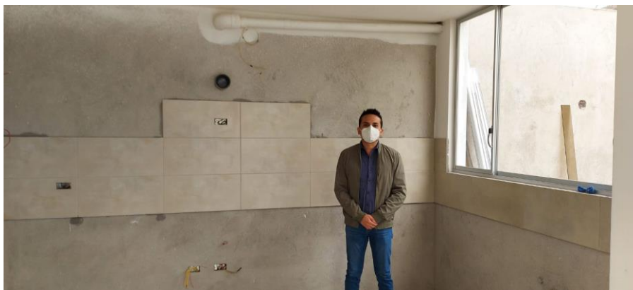
Fotografía 16: Casas en Construcción Arcángeles IV Autor: Angel Vallejo Salazar
