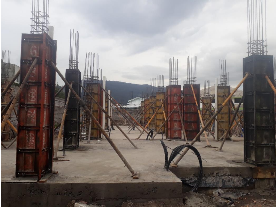
Fotografía 50: Fundición de Columnas
