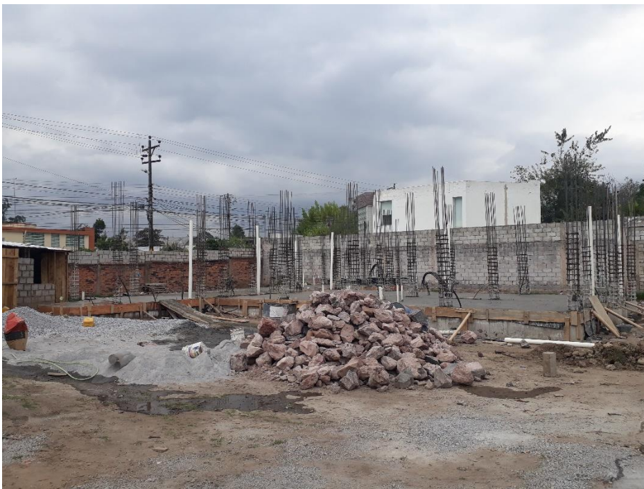
Fotografía 49: Fundición de Contrapiso
