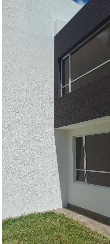
Fotografía 23: Grafiado Pintura Exterior
