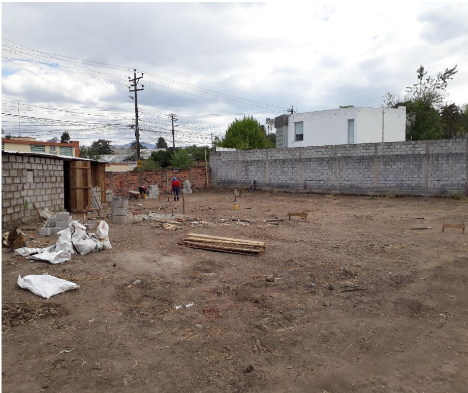
Fotografía 45: Replanteo Autor: Angel Vallejo Salazar
