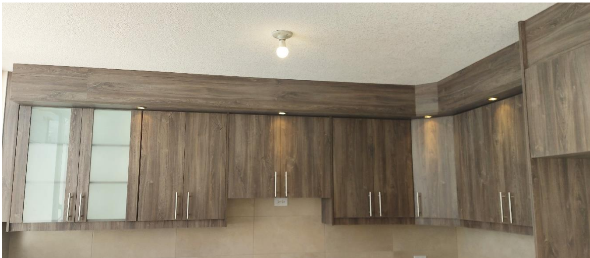
Fotografía 37: Cenefa de Iluminación Cocina
