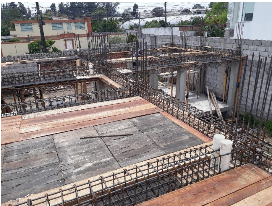
Fotografía 51: Encofrado de Losa y Colocación de Vigas
