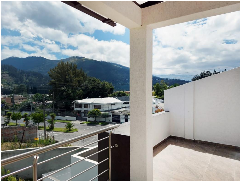
Fotografía 100: Terraza Cubierta Autor: Angel Vallejo Salazar
