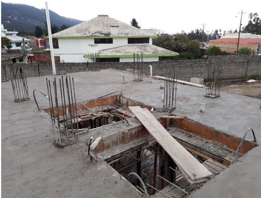
Fotografía 52: Fundición de Losa Planta Baja
