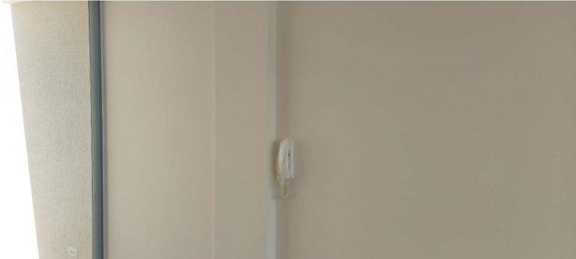
Fotografía 24: Pintura Paredes Interiores Autor: Angel Vallejo Salazar
