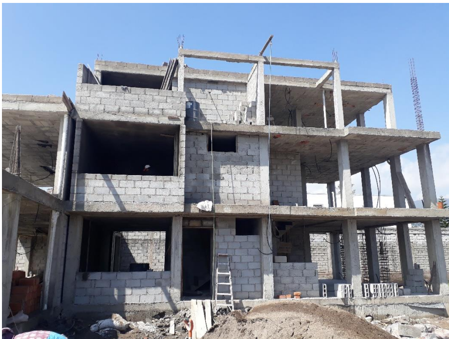
Fotografía 53: Colocación de Bloques en Paredes
