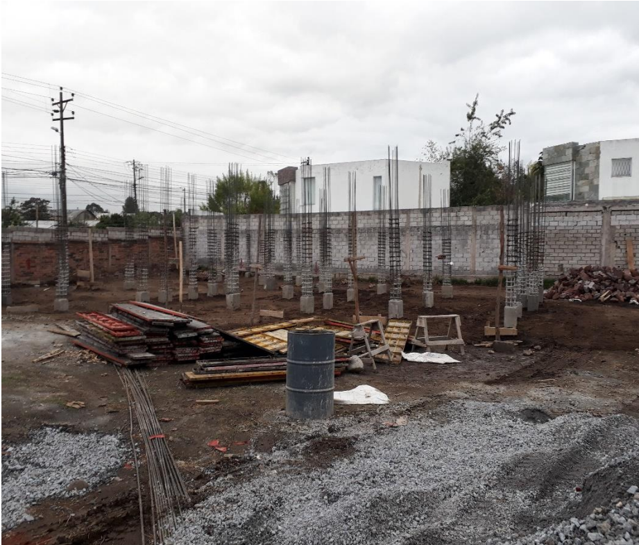
Fotografía 48: Relleno y Compactación Autor: Angel Vallejo Salazar
