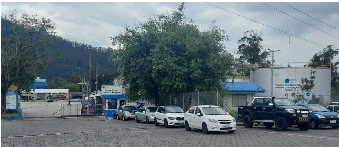
Fotografía 14: Central Térmica Guangopolo
