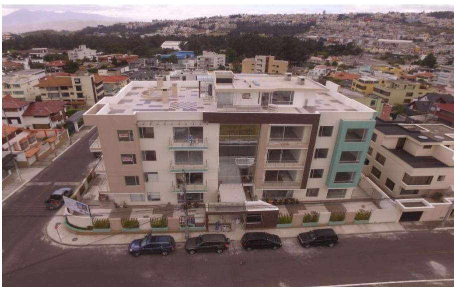
Fotografía 7 Fachada de edificio 2, ubicado en la zona permeable.
