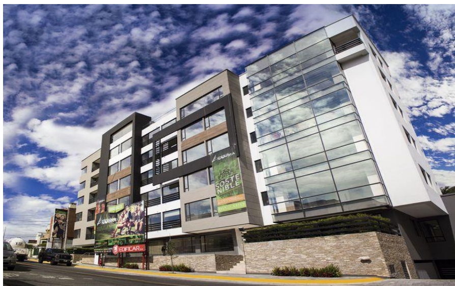
Fotografía 6. Fachada de edificio 1, ubicado en la zona permeable.
