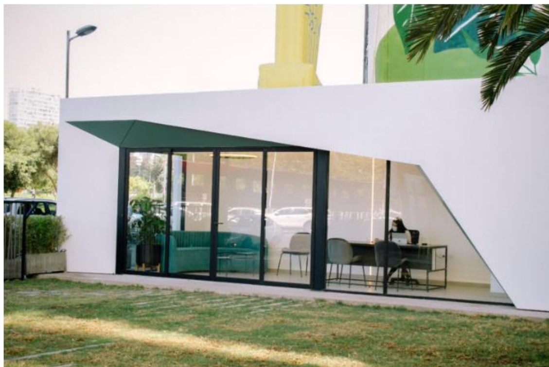
Ilustración 7.9.a. Oficina de Ventas Promotor Rosero Construye. Fuente: dolcevita.ec
