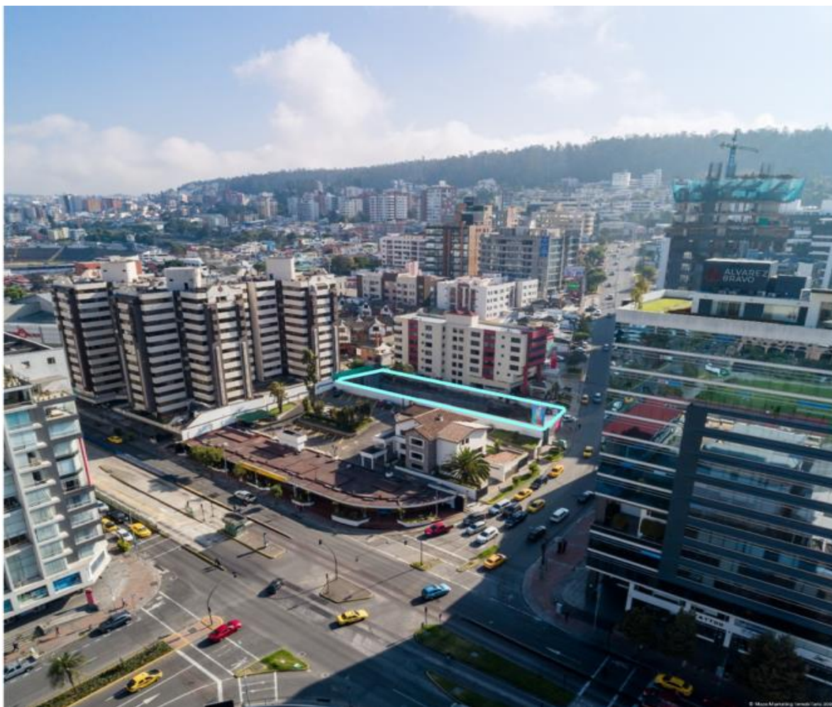
Ilustración 7.6.2.c Vista Aérea Proyecto Cielo. Fuente: Rosero Construye
