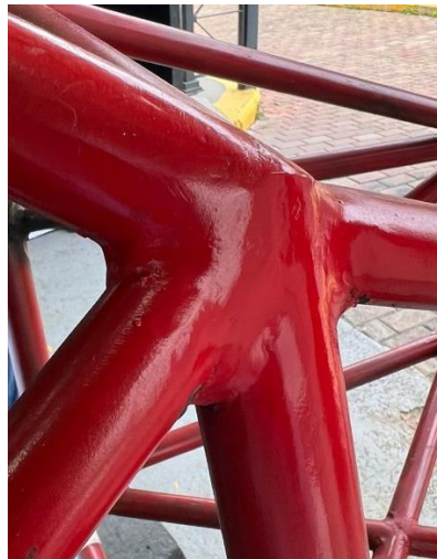
Figura 18. Junta de soldadura luego de limpieza, pulido y pintado.
