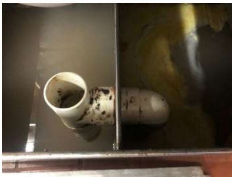
Figura 22. Trampa de grasa de las cocinas de la USFQ
