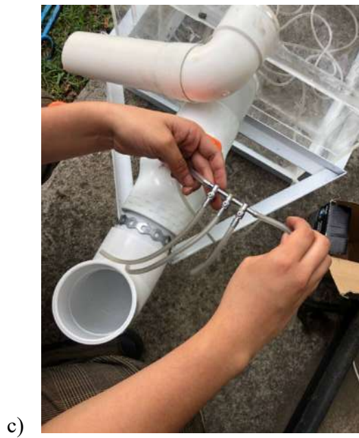
Figura 18. Sistema de aireación
