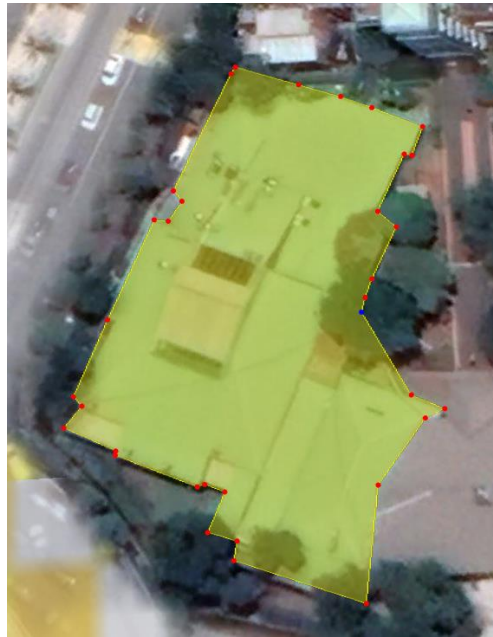
Figura 24. Techo Edif. Aristóteles
