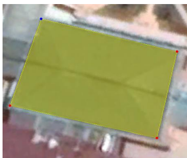
Figura 4. Techo Edif. Darwin
