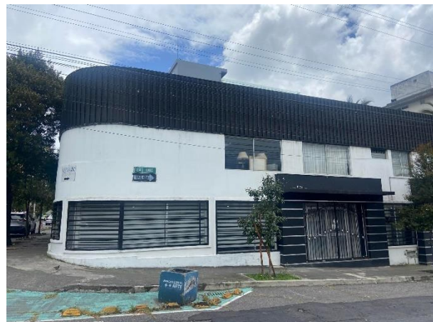
Figura 9. Fachada calle Lugo
