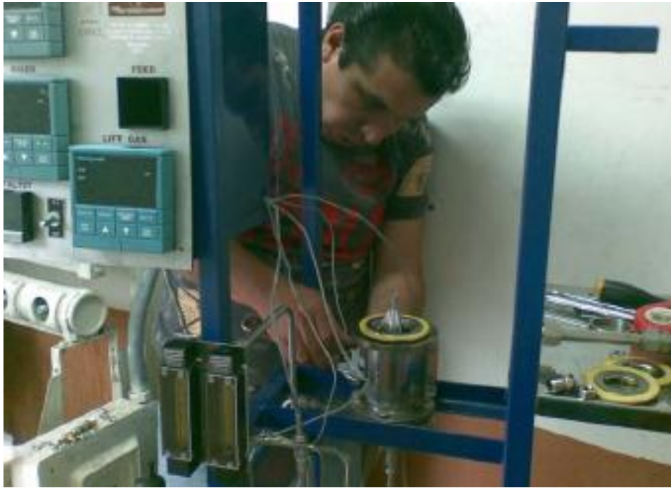
Instalación del Sistema Eléctrico
