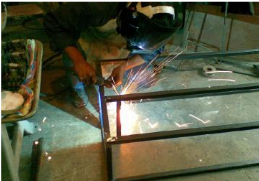
Estructura Metálica del TCE
