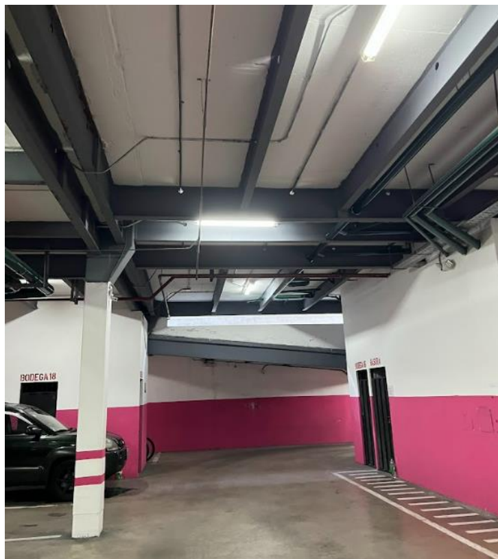
Anexo A. 3: Vista de las vigas, viguetas y columnas en el primer subsuelo
