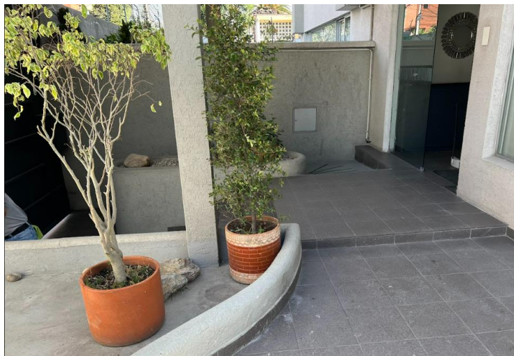
Anexo A. 1: Entrada al edificio, a 1m sobre el suelo
