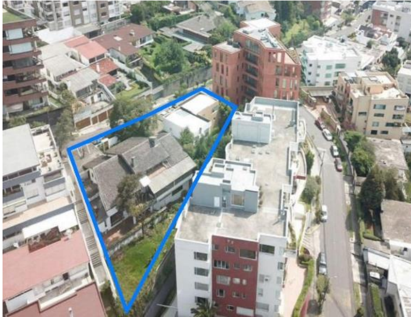
Ilustración 22. Toma aérea predios del proyecto
