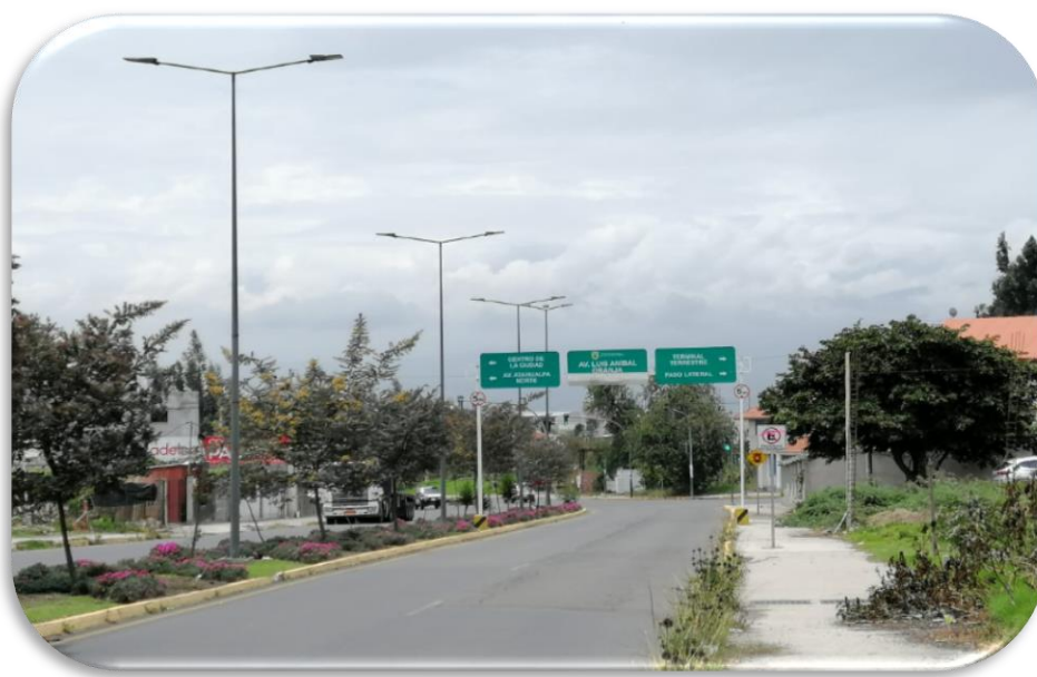
Ilustración 23: Avenida Luis Aníbal Granja – Ambato Fuente: Propia
