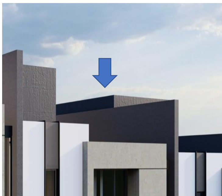
Ilustración 143: Lugar de instalación de los paneles solares en las viviendas Fuente: Autor
