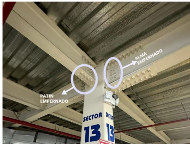
Figura 9: Viga I con placa de cortante empernada.
