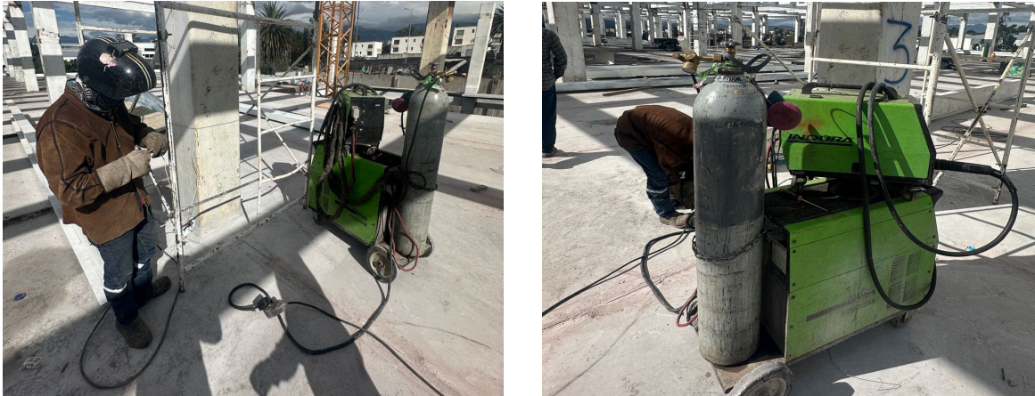
a) Operario de soldadura: Soldador
