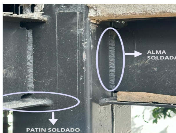
Figura 4: Viga I soldada patín y alma.
