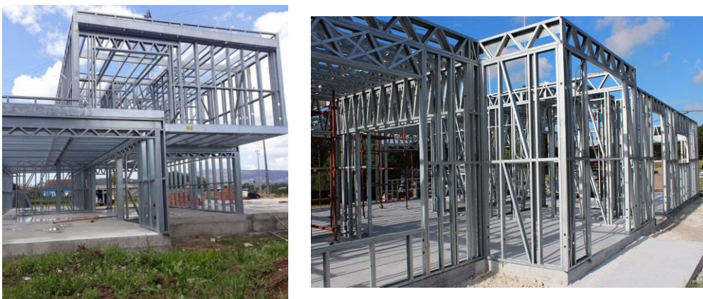
Ilustración 1 Paredes de Steel Framing
