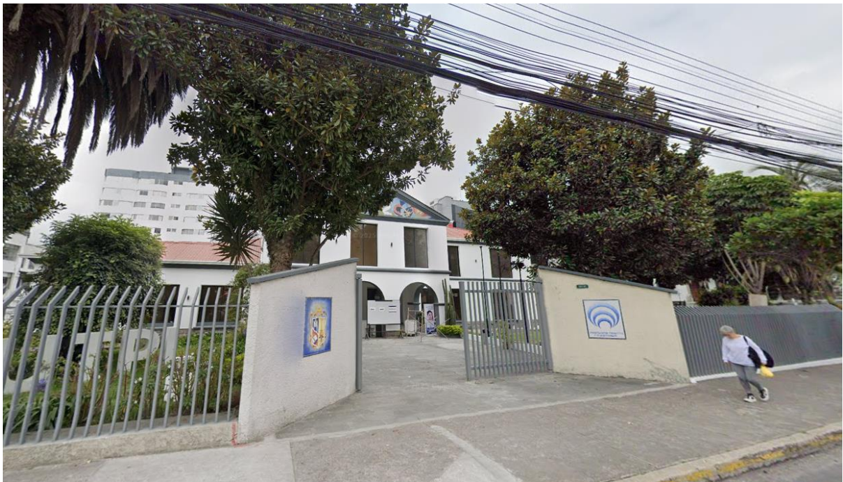
Fachada frontal. Imagen obtenida de Google Maps.
