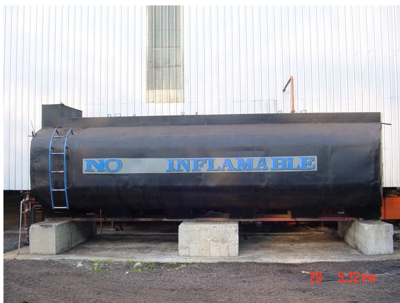
Foto 15. Tanque de almacenamiento.
