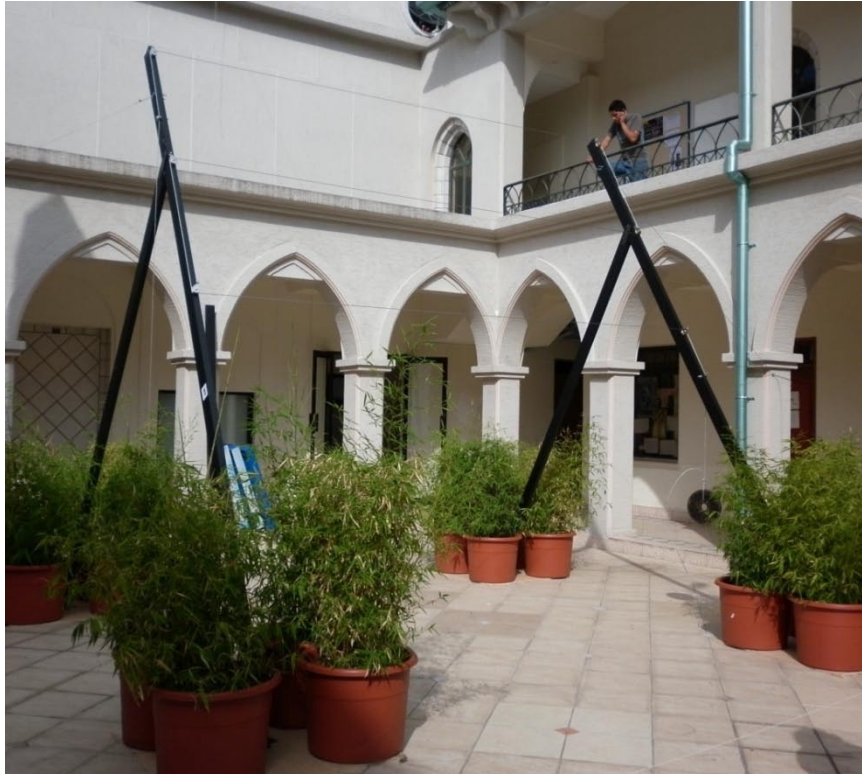
Figura D- 1: Estructura en Tierra Ensamblada.
